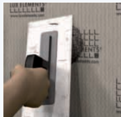
Gröp ca. \varnothing 50 mm ur skivan såsom bilden visar. Fyll ut med COL-AK. Borra och plugga efter att fixeringslimmet härdat.
