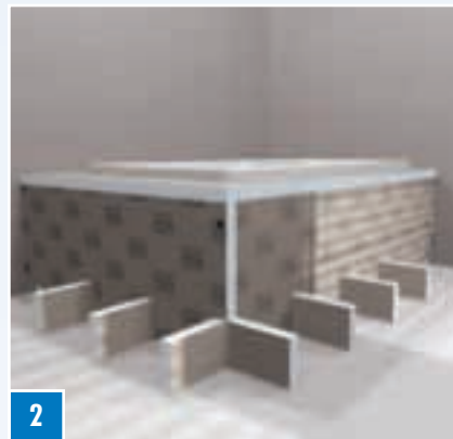
2 Tillverka fackverk för trappsteget av ELEMENT-EL 50. Limma fast dem med COL-MK med c-avstånd 300 mm.
