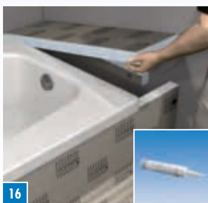
16 Såga till hyllplanet enligt mått, applicera COL-MK på vägglisternas ovankant. Lägg sedan på hyllplanet och tryck till.
