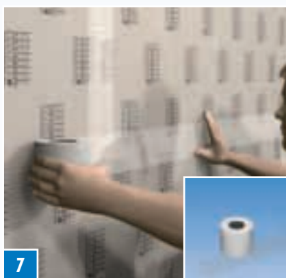
7 Alla fogar måste täckas över med armeringsväv ARM-100 SK.
