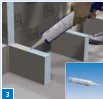
3 Tillverka stegens front- och ovsida av ELEMENT-EL 50. Lägg COL-MK i en obruten sträng på de friliggande ovan- och sidokanterna ...
