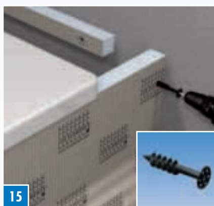
15 Tryck fast frontskivan under karetets kant mot vägglisten och gavelsidan. Fäst frontskivan i vägglisten med två stycken FIX-SD 80 samt i gavelskivans kant med ytterligare två fixeringskruvar. TIPS: Plugghålen ska göras i förväg med en krysspårskruvmejsel.
