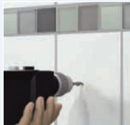
kontrollera att håltagning görs mot bakomvarande regel, kotling eller konstruktionsdetalj.
