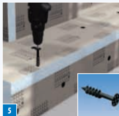
5 Fixera stegens ovan- och sidodel med FIX-SD 80. TIPS: Plugghålerna ska göras i förväg med en krysspårskruvmejsel.
