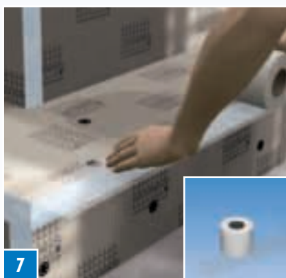
7 Samtliga skarvar och övergångar ska armeras med glasfiberarmeringsremсор ARM-100 SK.
