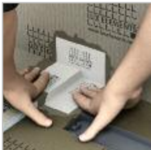
DRY-DBIE LINE – Dichtband für Innenecken, für TUB-LINE mit einseitigem Gefälle
