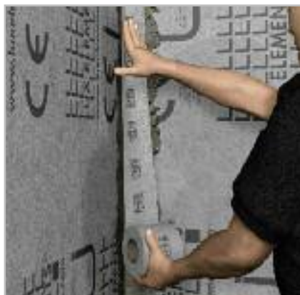
Stöße und Ecken mit DRY-DBV abdichten
