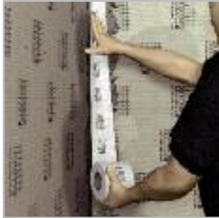
DRY-DB(V) – Dichtband in Wand/ Bodenanschlüsse einarbeiten
