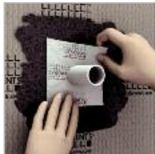
DRY-DBWM – Rohrdurchführung eindichten
