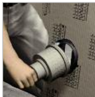
Fest verbundener Bodenablauf-Stutzen
