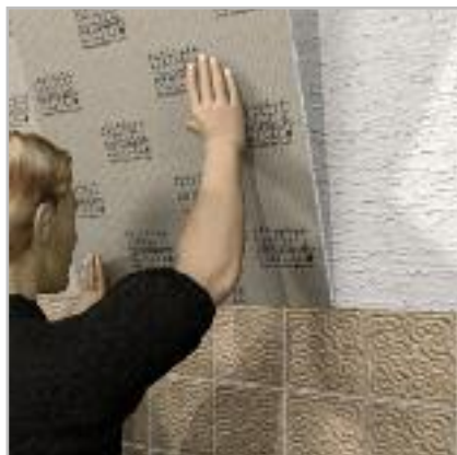
ELEMENT-EL – zum Ansetzen auf Wänden (z. B. als Wandausgleich über alten Fliesenbelägen), ...
