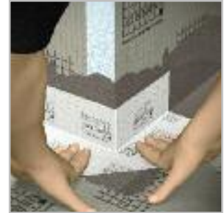
DRY-DB(V)AE – Außenecken ausbilden
