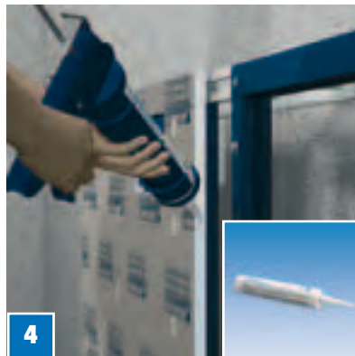
4 ELEMENT-rakennuslevyt liimataan päällekkäin COL-PU-kiinnitysaineella. Levitä aine levyjen reunoille katkeamattomana raitana.
