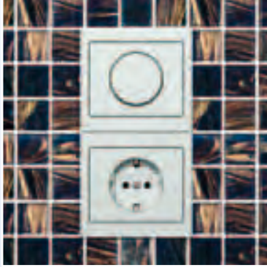
Pistorasioiden ja katkaisimien asennus...
