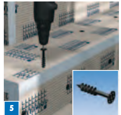
5 Kiinnitä vielä kansi ja sivut FIX-SD 80-ruuveilla.
