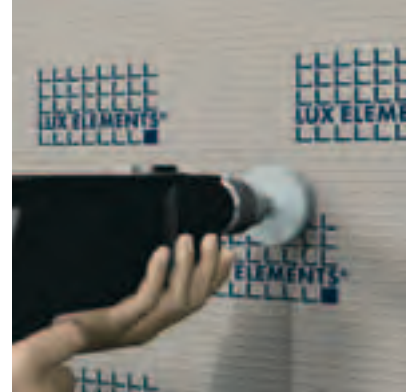
Poraa elementtiin reikä rasiaporalla.
