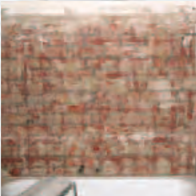
Kylpyhuoneen seinä ennen ELEMENT-rakennuslevyjen asentamista...
