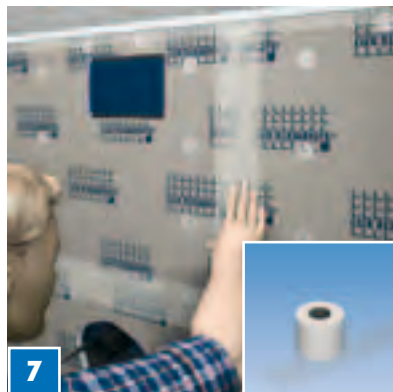
7 Vahvista kaikki elementtien saumat ja liitoskohdat ARM-100 SK -lasikuitunauhalla...
