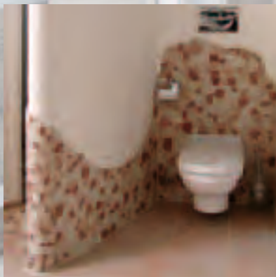
Kaareva seinärakenne tilanjakajana kylpyhuoneessa
