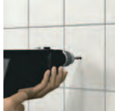
Laattaan porataan reikä sopivaa ontelotulppaa varten.
