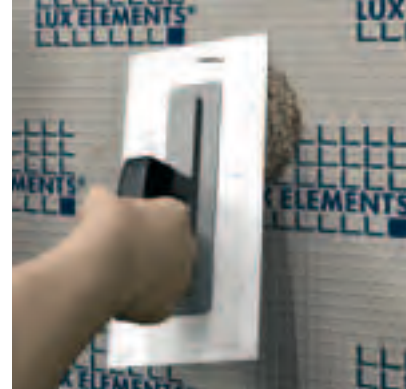
Leikkaa solumuovielementtiin kuvan mukainen kolo. Täytä COL-AK-kiinnitysaineella. Tee kiinnitys myöhemmin kovettuneeseen COL-AK-massaan.
