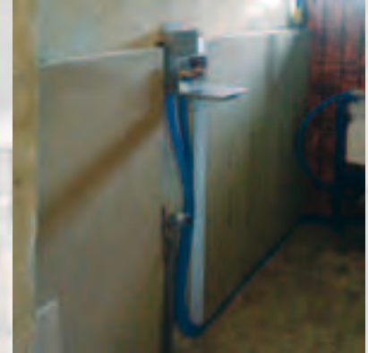
Seinä valmiina saniteettiasennusta varten
