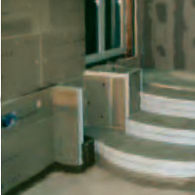
Poreallas, jossa on koroke ja hyllyt ennen laatoitusta
