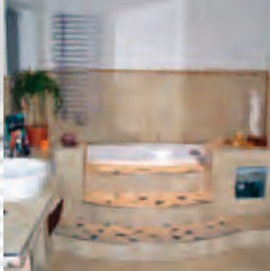
Poreallas, jossa on koroke ja hyllyt, laatoitus valmis
