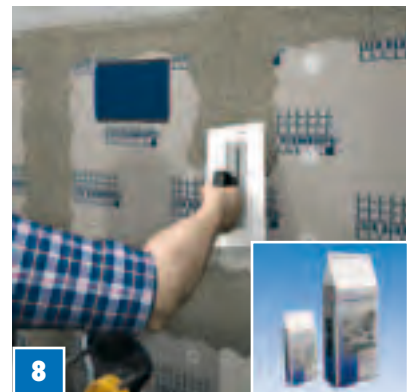
8 ...ja tasoita lopuksi elementtien saumat ja päädyt COL-AK-kiinnitysaineella. Pinta on nyt valmis laatoitettavaksi. Paikallisia määryksiä esim. vedeneristyksestä on noudatettava.
