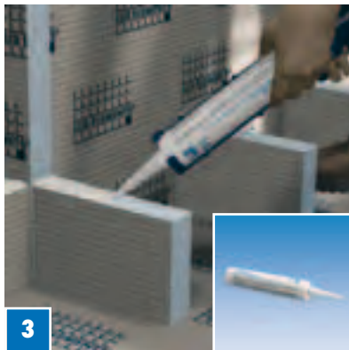
3 Levitä COL-PU-kiinnitysainetta aaltomaisena kuviona tukielementtien ylä- ja sivupintoihin.
