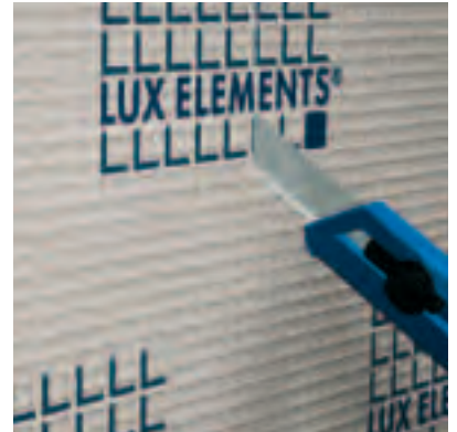
Leikkaa tukielementtiä yhdensuuntaisesti leikkurilla, poista solumuovia tarvittava määrä sopivalla työkalulla (esim. ruuvimeisselillä), aseta rasia paikoilleen ja täytä kolot COL-PU- tai COL-AK-kiinnitysaineella.
