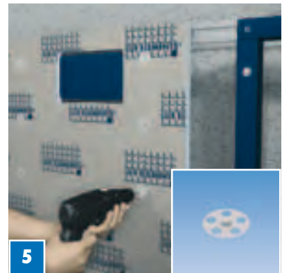
5 Ruuvauksessa tulisi käyttää FIX-S 35-aluslevyjä ja sopivia ruuveja. Ristisaumat ovat kiellettyjä. Noudata välimatkoissa seinälle asennetun rakenteen valmistajan suosituksia.
