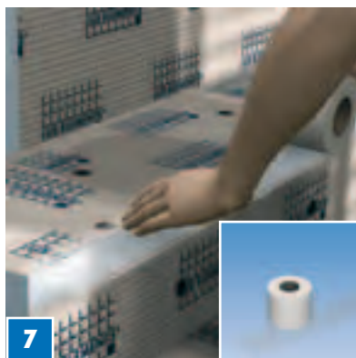
7 Kaikki elementtien saumat vahvistetaan ARM-100 SK-lasikuitunauhalla...
