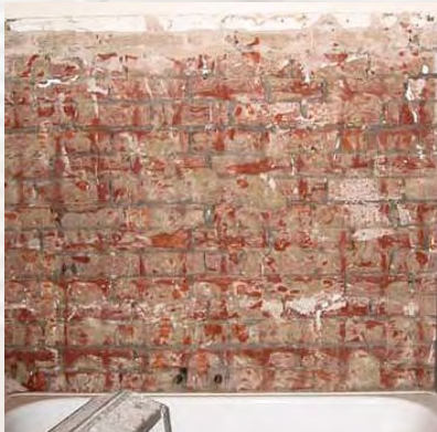
Badeværelsesvæg i rå tilstand før beklædning med ELEMENT byggeplader ...
