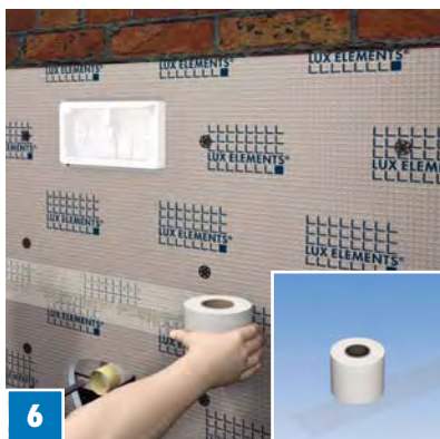
6 Samtlige pladesamlinger skal armeres med glasfibervævet ARM-100 SK. Til sidst spartles de armerede pladesamlinger med COL-AK
