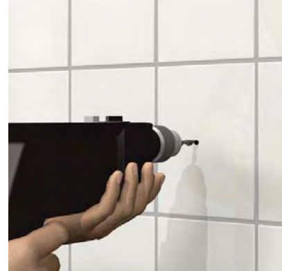
Bor i flisen for at anvende en egnet hulrumsdyvel.
