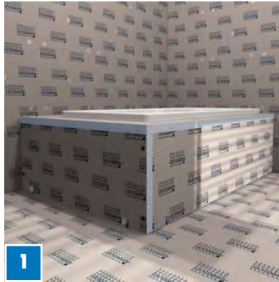
1 Lav en badekarsbeklædning uden fodspark; beskrevet på side 16–17.
