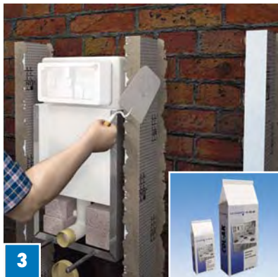
3 Påfør COL-AK på udligningskonstruktionens endeeflade og sæt en tværgående, tilskåret og udskåret ELEMENT-EL 20 på denne endeeflade.
