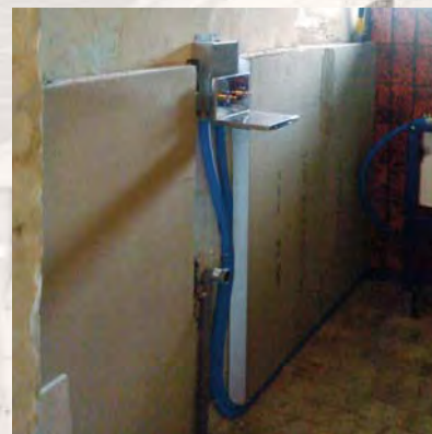
Forberedelse af en væg til en sanitær installation.
