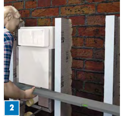
2 Afstanden mellem de tilskårne ELEMENT delstykker skal i gennemsnit være på 30–40 cm.
