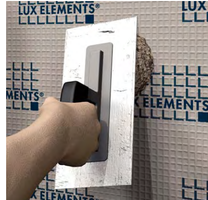
Skær i bæreelementet med en hobbykniv, krads hårdskummet ud og fyld op med COL-AK. Fastgør senere fastgørelsessættet i COL-AK.
