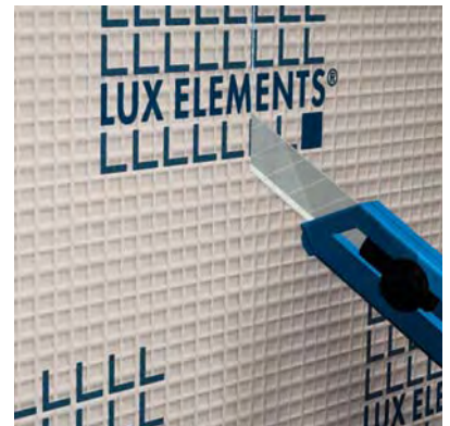
Skær parallelt i bærematerialet med en hobbykniv, fjern det nødvendige hårdskum med egnet værktøj (f.eks. en skruetrækker), og påfør spartelmassen COL-PU eller COL-AK.
