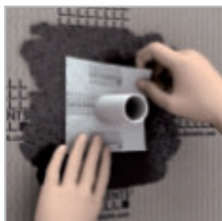
DRY-DBWM – Étanchéifier les passages de tuyaux
