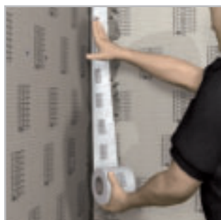
DRY-DB(V) – Appliquer la bande d'étanchéité sur les jonctions ou mur/mur
