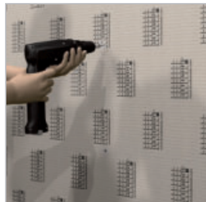
ELEMENT-EL – le panneau de construction universel à visser sur une ossature en bois ou en métal ...
