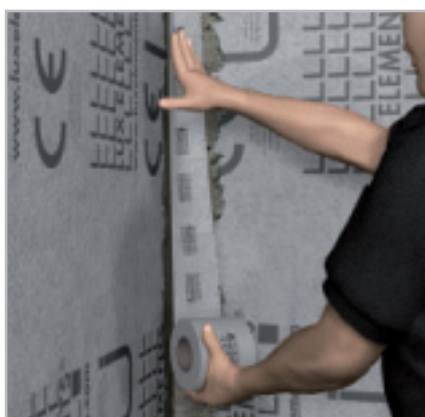
Étanchéité des raccords et angles avec DRY-DBV
