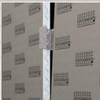
Accessoire de montage permettant le raccordement d'éléments porteurs en mousse dure les uns aux autres, par exemple pour prolonger une cloison.
