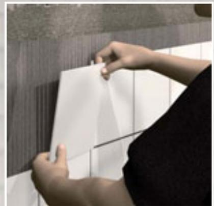
Pose du carrelage suivant le procédé de collage simple. Appliquer avec une truelle dentée la colle à carrelage sur toute la surface.
