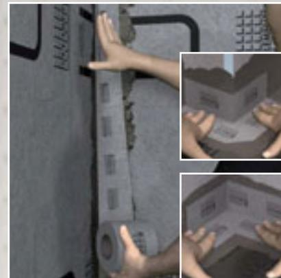
L'étanchéification sûre des jonctions dans les angles s'effectue avec une bande d'étanchéité pare-vapeur et les pièces préformées appropriées.
