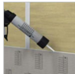
Grâce à ses propriétés la colle de montage LUX ELEMENTS®-COL-MK appliquée entre deux panneaux, suffit en locaux privatif à garantir l'étanchéité de l'ouvrage.
