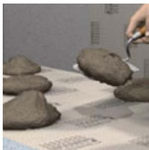
Avant l'application de la colle, pré-percer avec un tournevis cruciforme le trou de la cheville sur les positions des galettes de colle.
