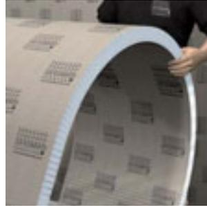
Il est conseillé de porter les panneaux dans l'état courbé, le côté rainuré vers l'intérieur.
