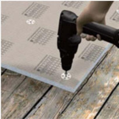
Les éléments porteurs en mousse dure sont vissés sur des planchers en bois avec des vis appropriées et des rondelles adaptées.
