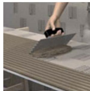
En cas d'utilisation de ELEMENT-EL Baby 4, **toujours** appliquer le colle de montage COL-AK au moyen d'une spatule dentée.
