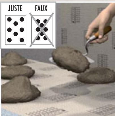
Pour une égalisation de hauteur sur des supports irréguliers, appliquer de la colle d'application ponctuellement au moyen de galettes de colle (8 à 10 galettes par m<sup>2</sup>).
