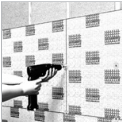
Wall cladding on stud frames
